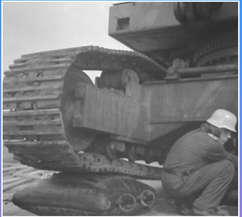
Die Ausrüstung für Hilfeleistungen wurde auch 1975 wieder ergänzt wie hier mit der handbetriebenen hydraulischen Rettungsschere und Hebekissen, mit dem ein Bagger zu Demonstrationszwecken angehoben wurde. Bereits im Juni 1974 wurden Hebekissen M 100 für die acht RW der Kreisfeuerwehr beschafft.
